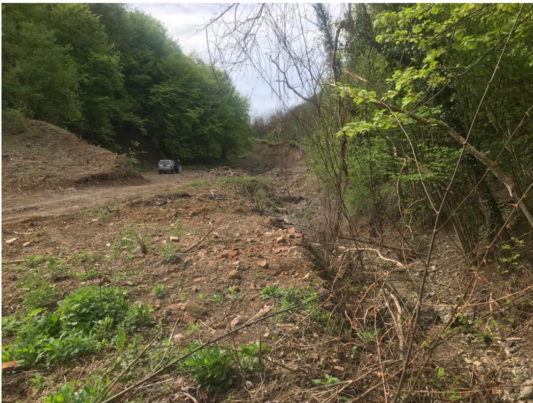
Slika 2-3: Postojeće stanje; degradirano korito potoka Pakao i deponirani materijal
