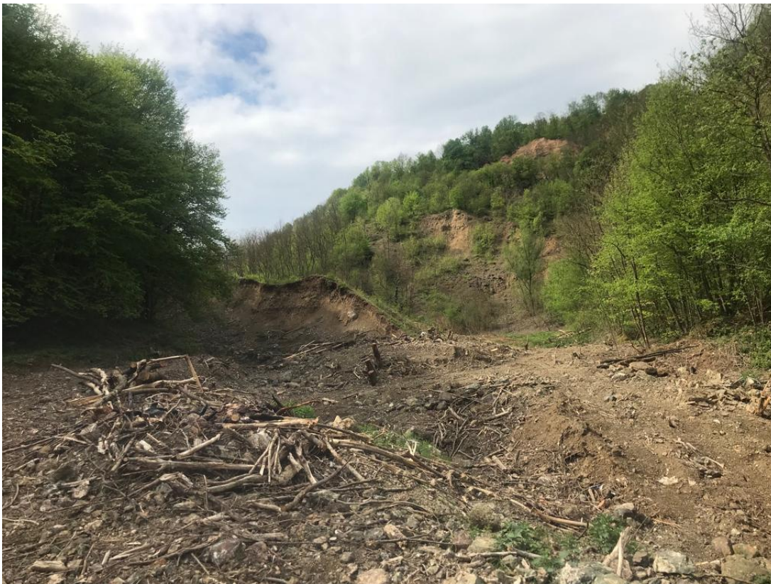
Slika 2-2: Postojeće stanje; ostaci nakupljene jalovine poslije prolaska bujičnog vala i potencijalno nestabilne padine u boku retencijskog prostora
