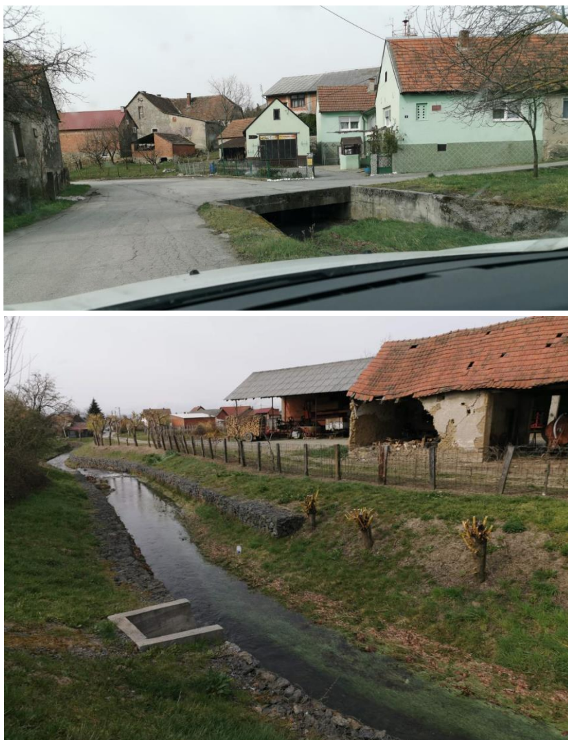
Slika 14. Postojeće stanje na lokaciji zahvata
