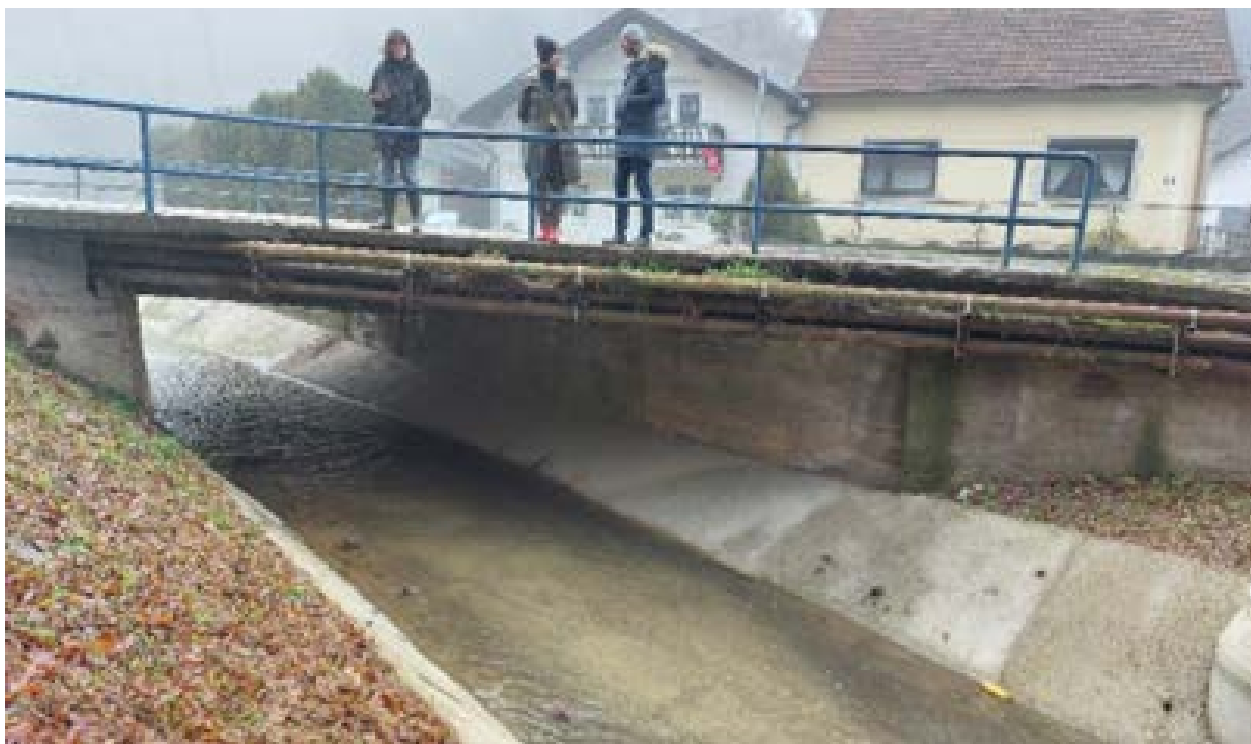
Slika 2.3-6 Most na križanju potoka Vučjak i ulice Jagodnjak (stac.km ~2+520)
