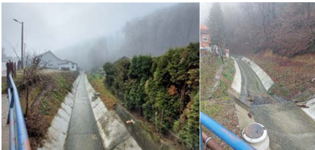
Slika 2.3-7 Novouređeno korito potoka Vučjak nizvodno(a) i uzvodno (b) od mosta na stacionaži km ~2+520
