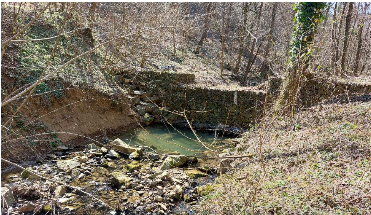
Slika 2.3-10 Gabionska pregrada na stacionaži km ~4+400.
