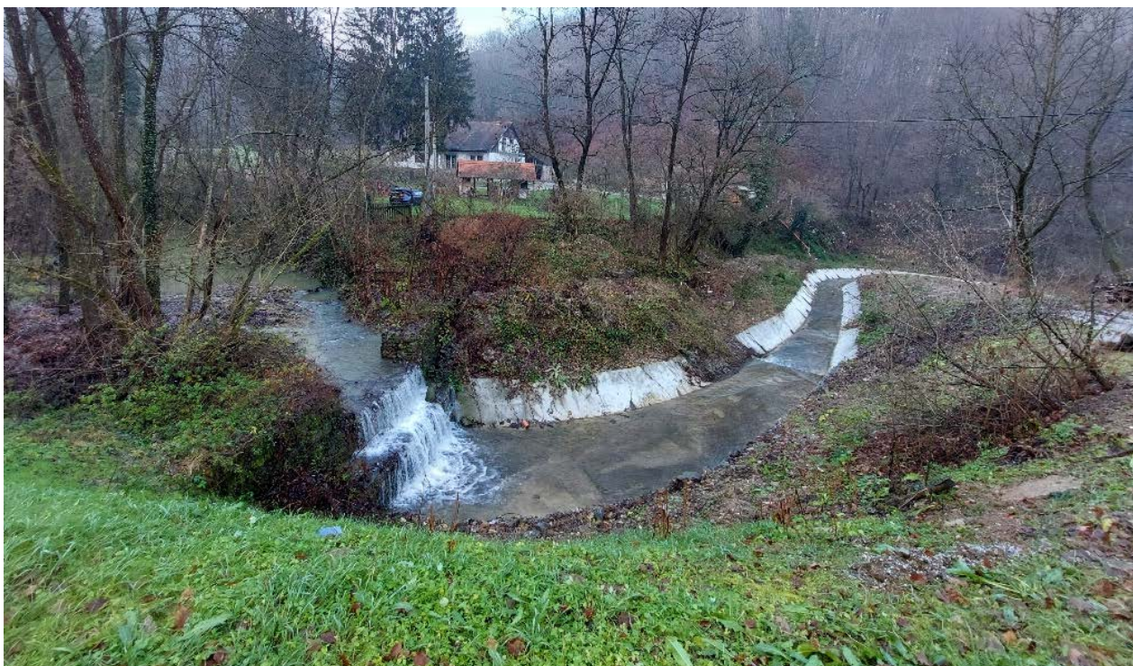
Slika 2.3-8 Završetak regulirane dionice i gabionska pregrada na stacionaži km ~3+950.
