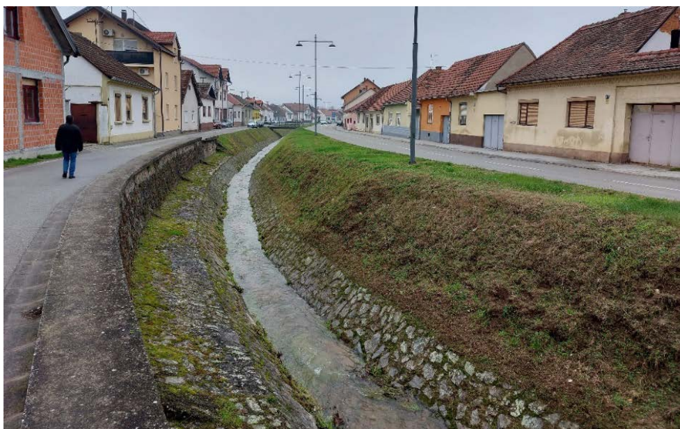
Slika 2.3-3 Uređeno korito potoka Vučjak do stacionaže km 0+535
