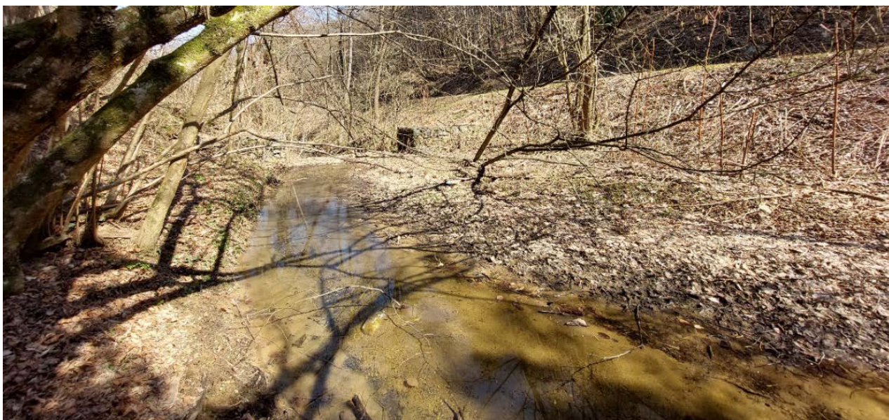
Slika 2.3-12 Gabionska pregrada na stacionaži km ~4+600.
