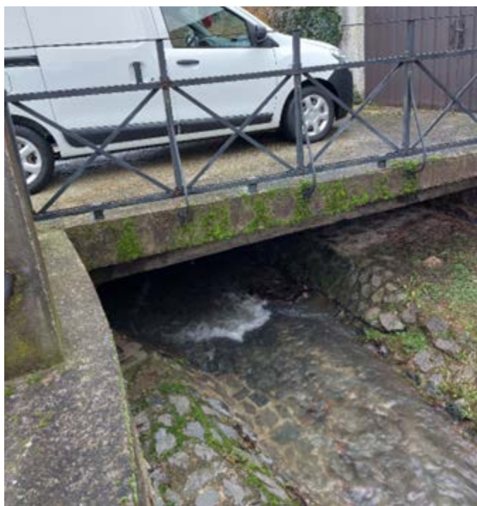
Slika 2.3-5 Ulaz potoka Vučjak u nadsvođeni dio (stacionaža km 1+091)
