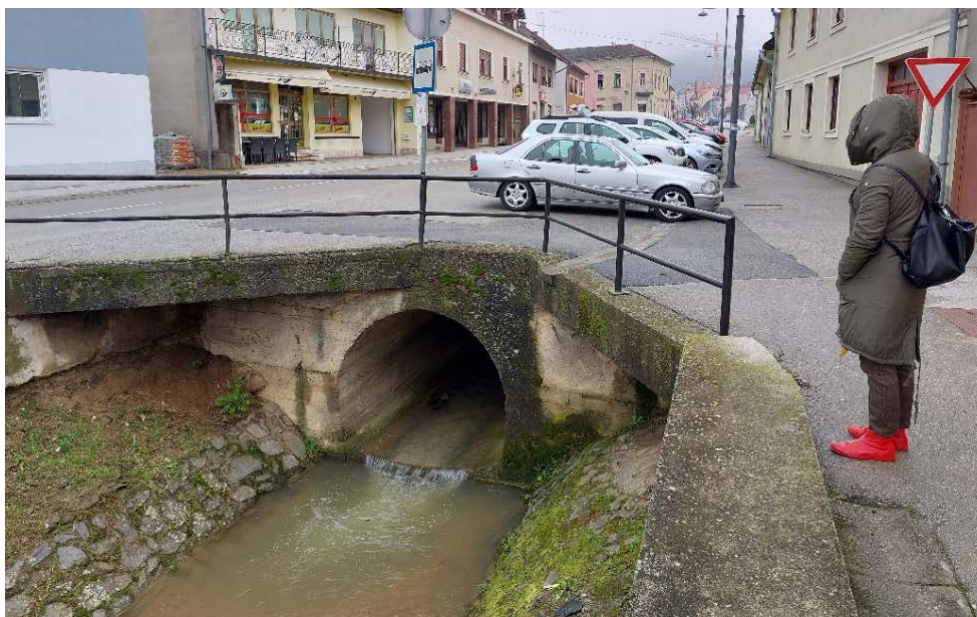
Slika 2.3-4 Izlaz potoka Vučjak iz nadsvođenog dijela (stacionaža km 0+535)
