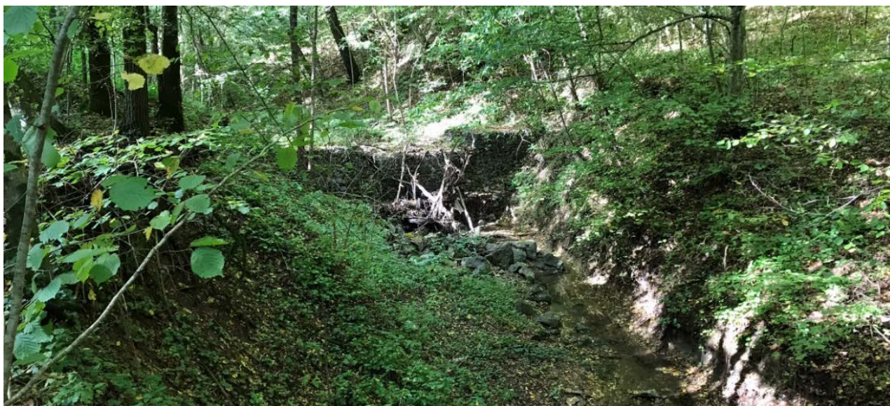
Slika 2.3-13 Gabionska pregrada na stacionaži km ~4+800.
