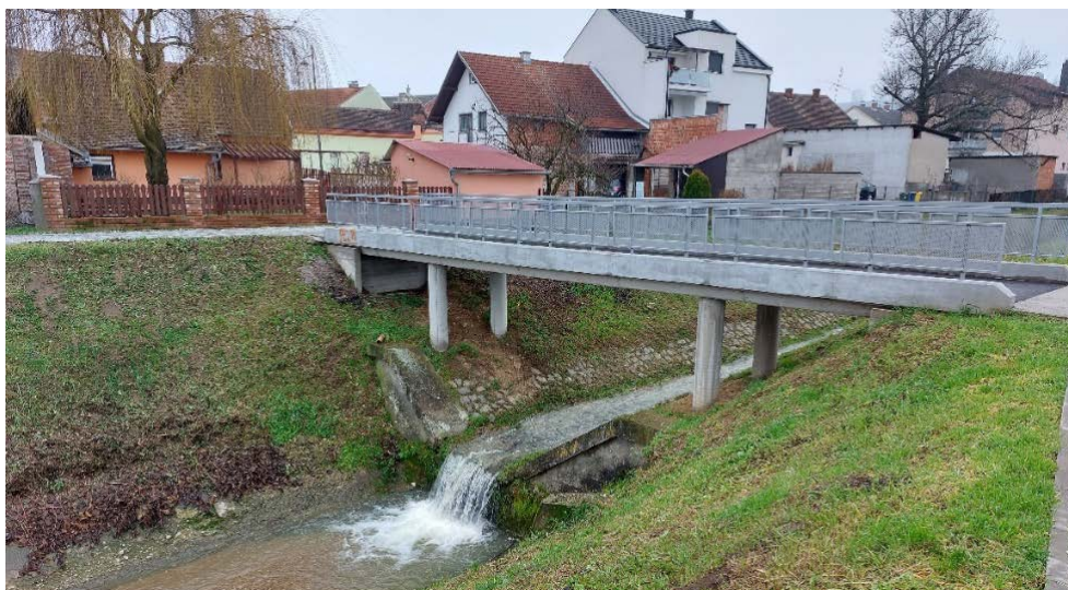
Slika 2.3-2 Vodna stepenica na stacionaži km 0+084
