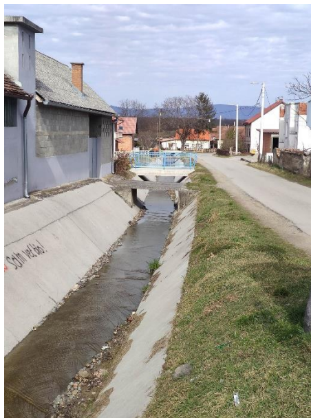
Slika 2.8. Uređeno korito vodotoka u naselju.
