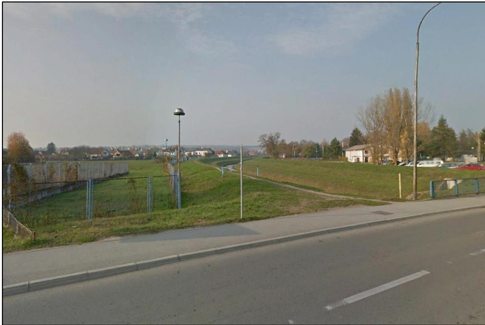
Slika 3.1.10.-1.: Pogled na početak zahvata na spoju sa Osječkom ulicom
