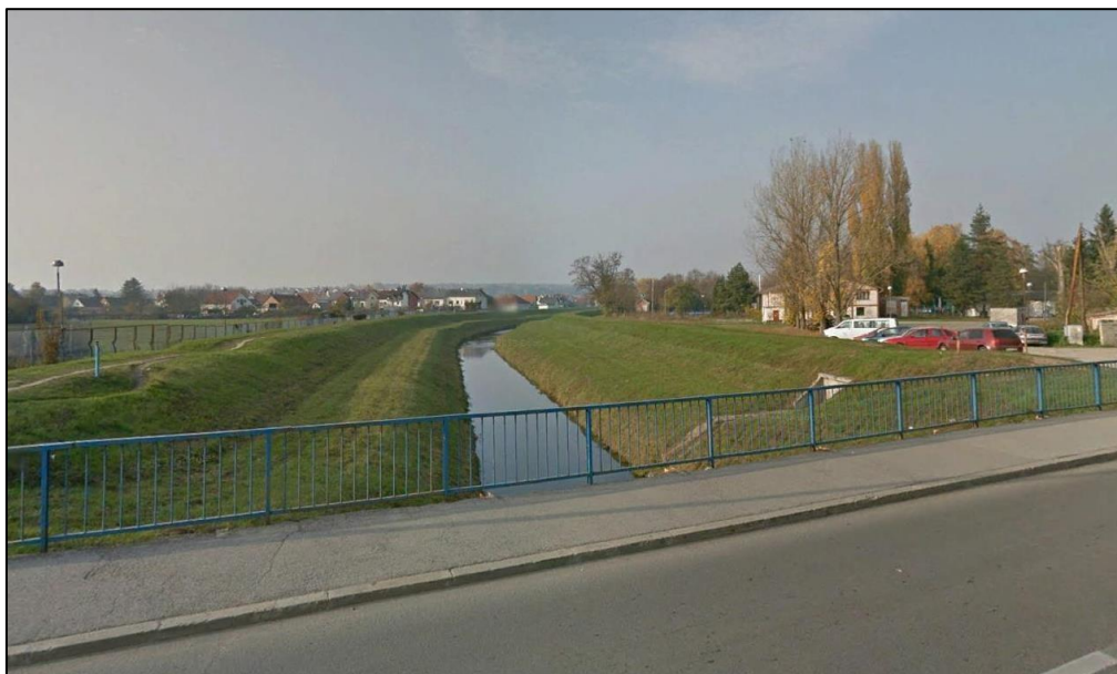
Slika 3.1.10.-2.: Pogled na uređeno korito Veličanke i desnoobalni nasip duž naselja Sajmište
