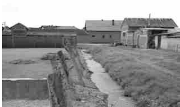
Slika 2: Gradac, „Pašnjak“- neprohodni kanali sa ustajalom vodom i ličinkama
